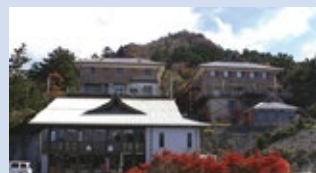
土小屋・白石ロッジ
